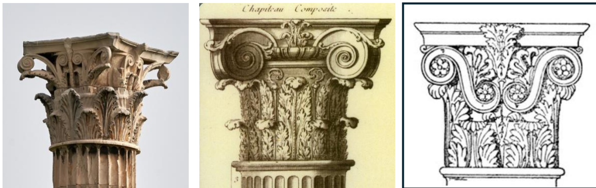
Abb. 63: Das korinthische Kapitell als Abschluss der Säulenordnung. Ganz links findet sich das Kapitell einer Säule aus dem Olympieion in Athen, datiert auf 170 v. Chr. Charakteristisch ist das Akanthusblatt, das die Voluten umspielt. Die 24-fachen Kanneluren bestimmen die Gliederung der Säule. Aus dem römischen Kapitell einer Komposit-Säule entwickelte sich schließlich die alles überragende S-Volute.
